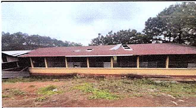
Foto1: Cambio de Láminas viejas por nuevas de tres aulas y una cocina.
