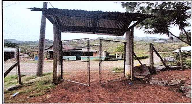
Foto 2: Cambio de portón de malla en mal estado por uno nuevo de metal.
