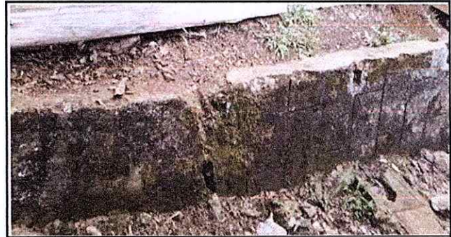
Foto 6: Mejoramiento de muro perimetral como base de postes de concreto y malla.
