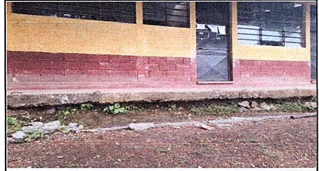
Foto 10: Ampliación de entortado corredor de dos aulas y Dirección.
