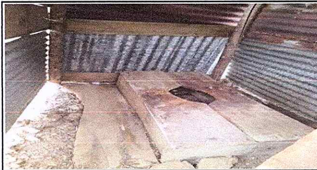
Foto 5: Sustitución de baños de madera para niños y niñas por dos de tazas de concreto.
