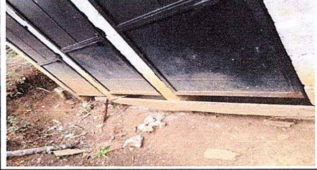
Foto 4: Cambio de tres chapas de baños en mal estado por tres chapas nuevas.
